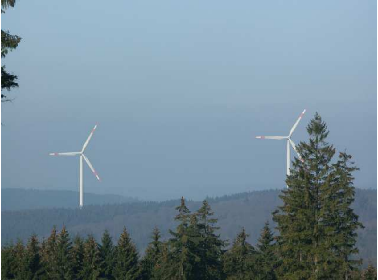
Abbildung 14: Windenergieanlagen im und über Wald
