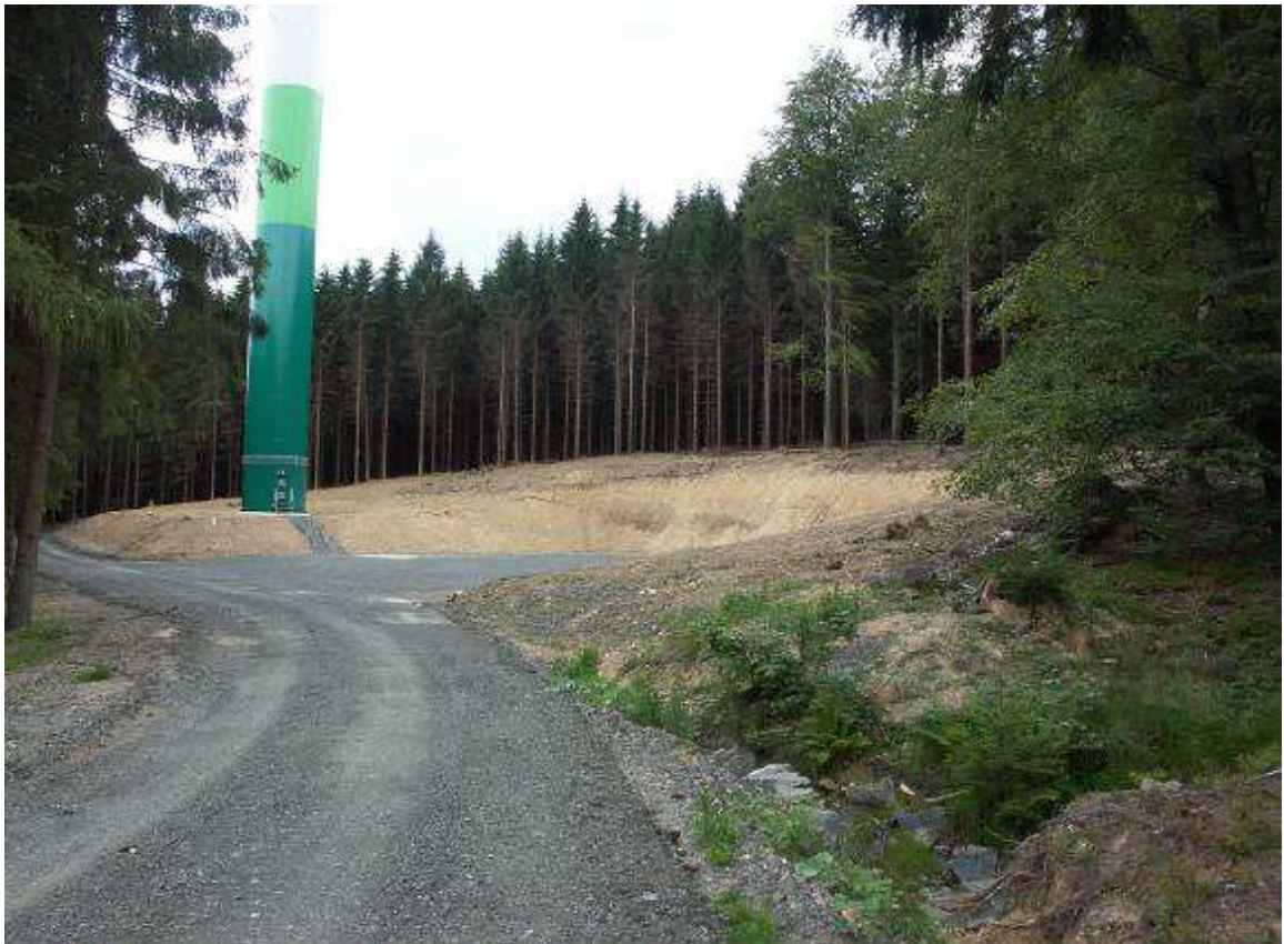
Abbildung 13: WEA-Standort, Zuwegung und ebene Kranstellfläche
