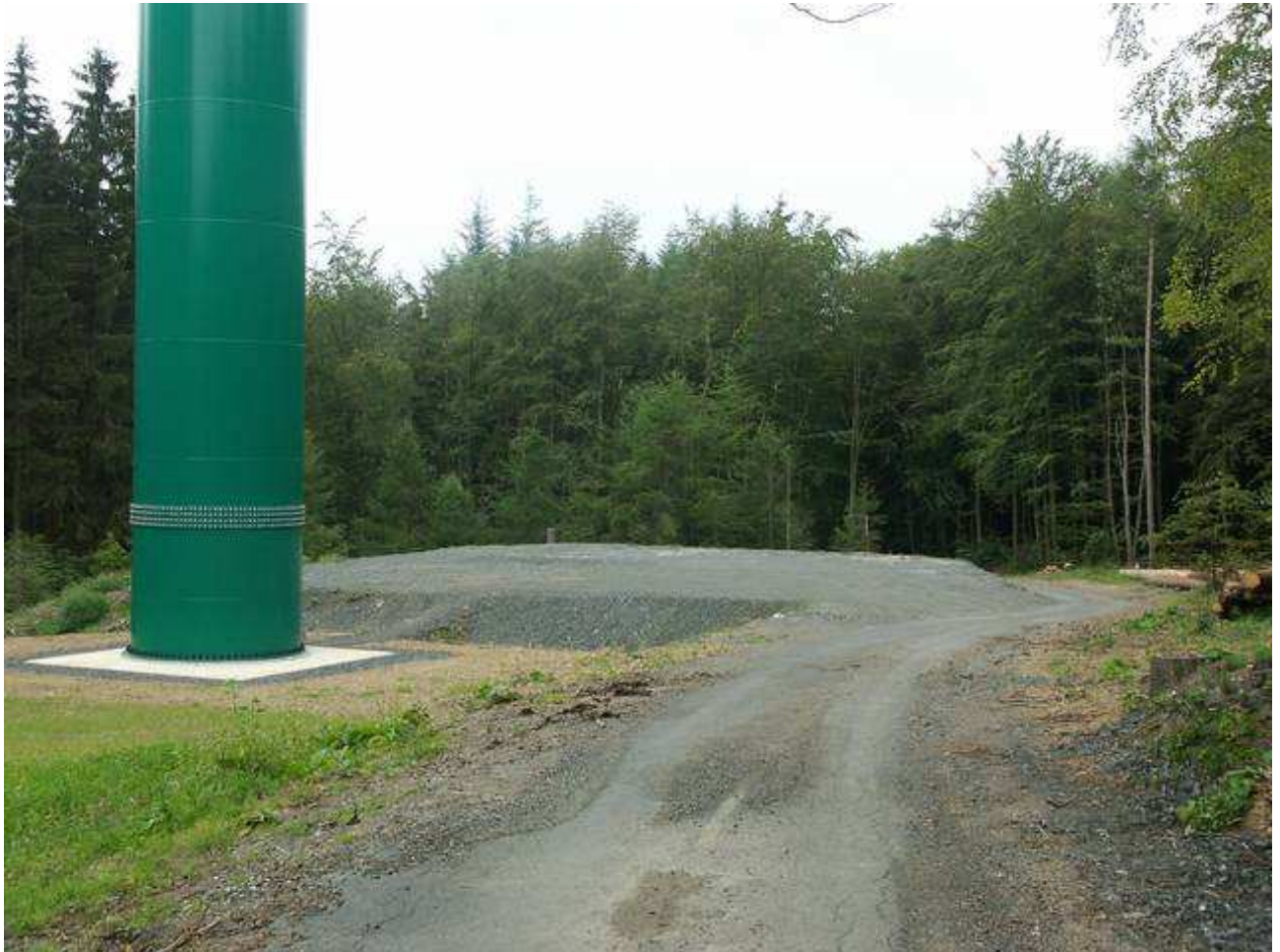
Abbildung 12: Standort, Zuwegung und Kranstellfläche
